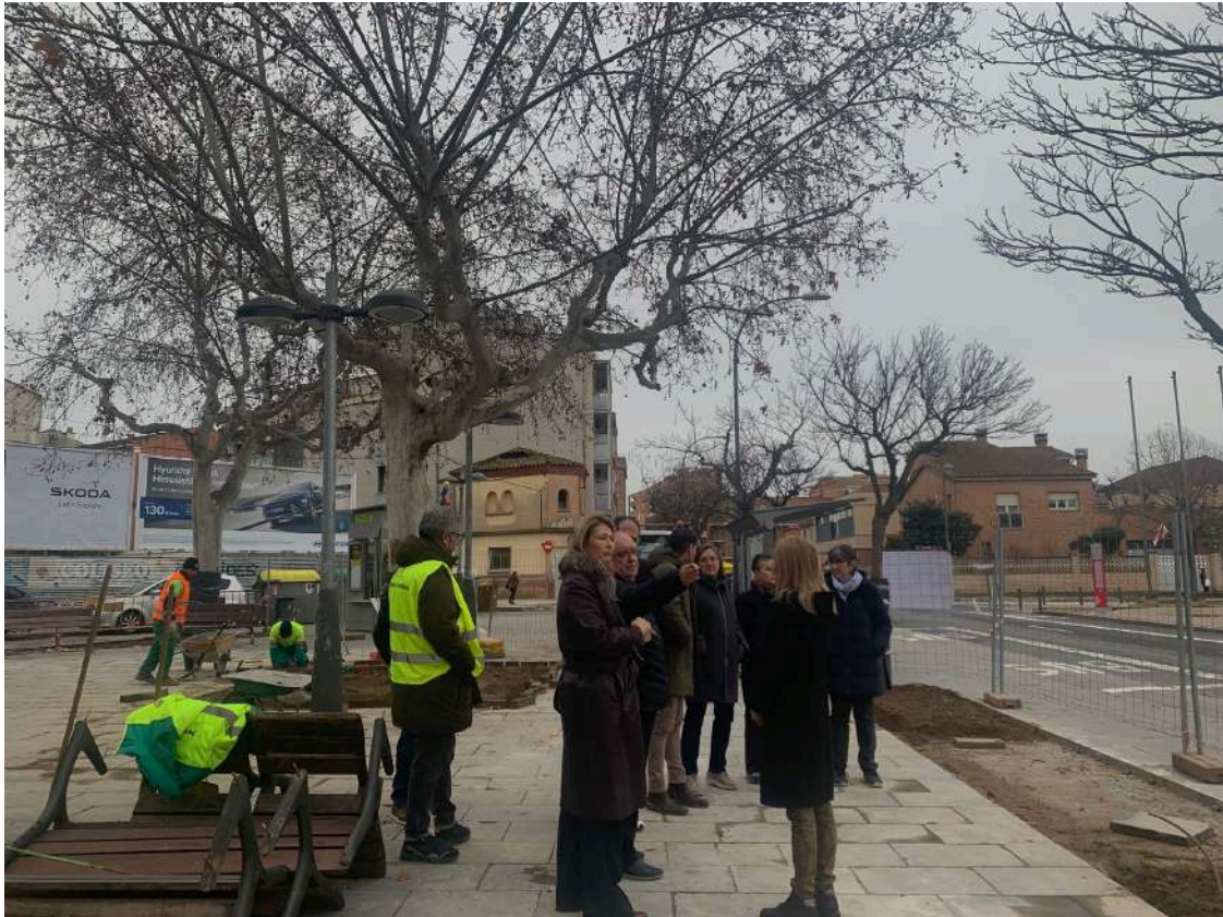
En marxa la renaturalització al barri la Bordeta de Lleida: la plaça de Sant Jordi es transforma
