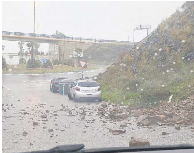
Desprendimientos en una ladera en Almuñécar.
