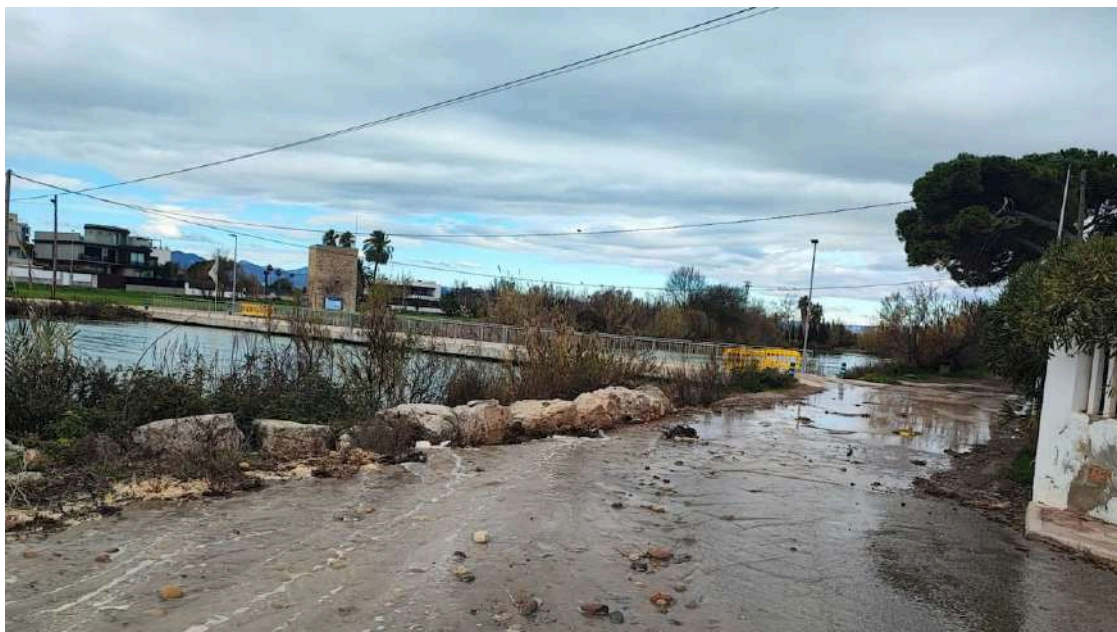
Burriana cuantifica en alrededor de 600.000 euros los daños causados por el temporal Harry en su costa
