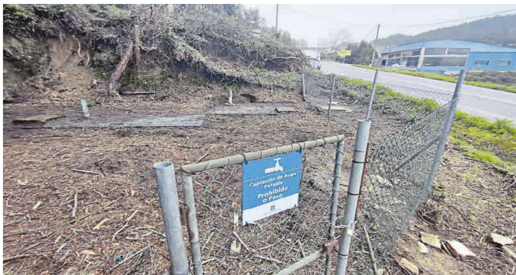
Depósito de Ourelo, que permanece cerrado, a pesar de que ya se limpió su interior. | Santos Álvarez
